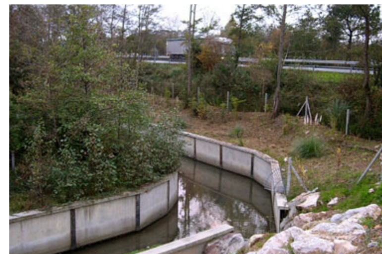
■ ■ ■ Zone de dérivation du grand Issaka (source Scetauroute)
