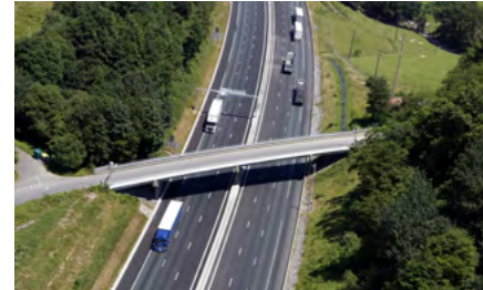
Le pont de la route de Kurleku
