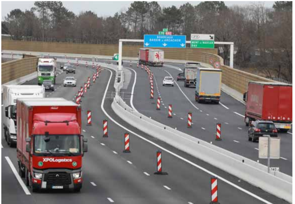
Les troisièmes voies dans chaque sens de circulation sont désormais tracées. La mise en service interviendra une fois obtenus les autorisations et l'arrêté préfectoral. PHOTO ISABELLE LOUVIER / « SUD OUEST »
