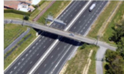
Pont de la route de Souhara
