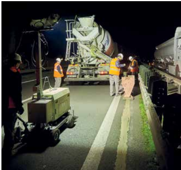
Opération de déviation de réseau de nuit.
