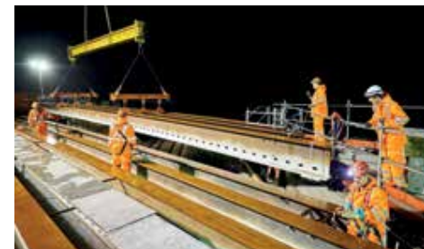
Pose des poutres de nuit.
