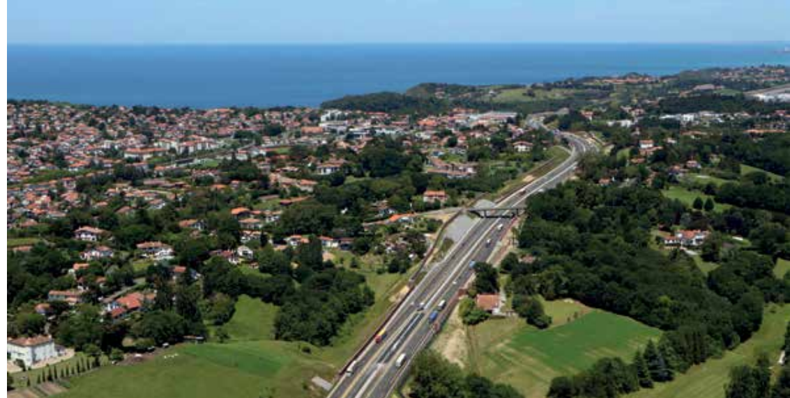
Vue aérienne du chantier.
