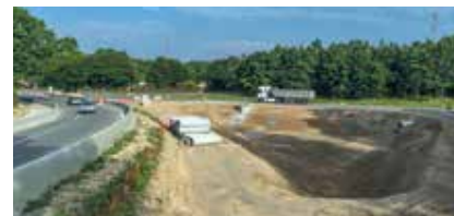
Le terrassement pour la création d'un des cinq futurs bassins.
