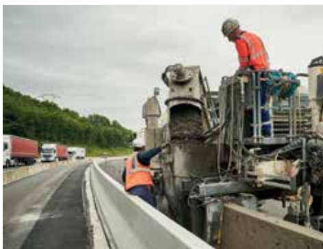
Mise en place des glissières béton sur le terre-plein central.
