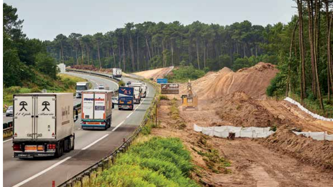
Terrassement des pistes latérales d'accès au chantier.
