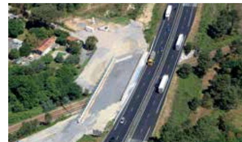
Le pont-route achevé.
