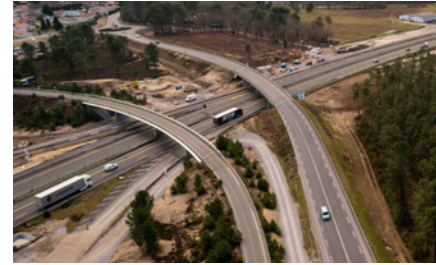
Le pont de la RD 810 avant travaux.
